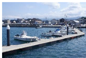
経田漁港の浮棧橋
