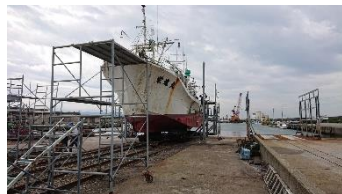
大型漁船用上下架施設
